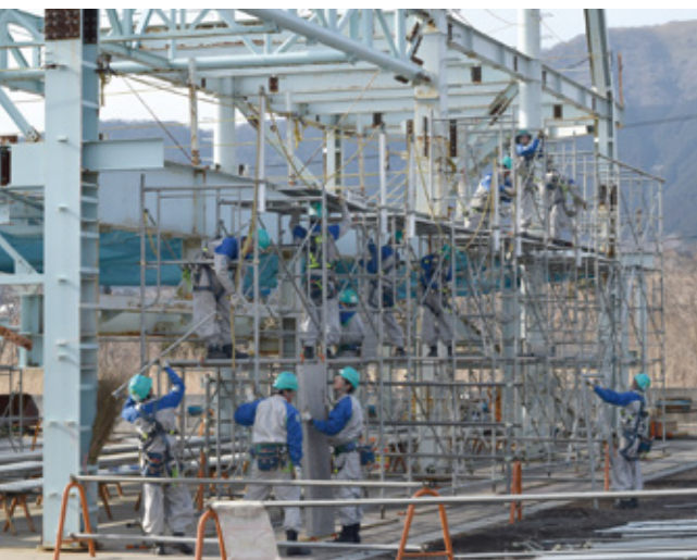
広い敷地内では足場の組み立て訓練もできる
